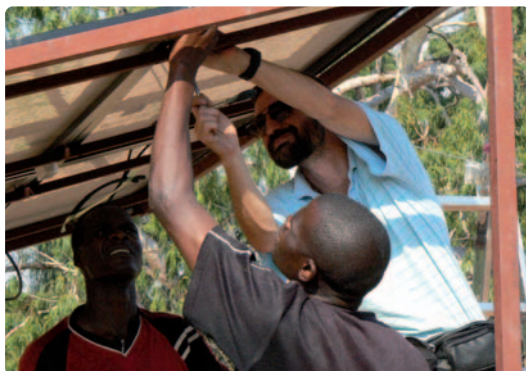
Foto: Martina Mandová, Montáž solárních panelů v Masuku
